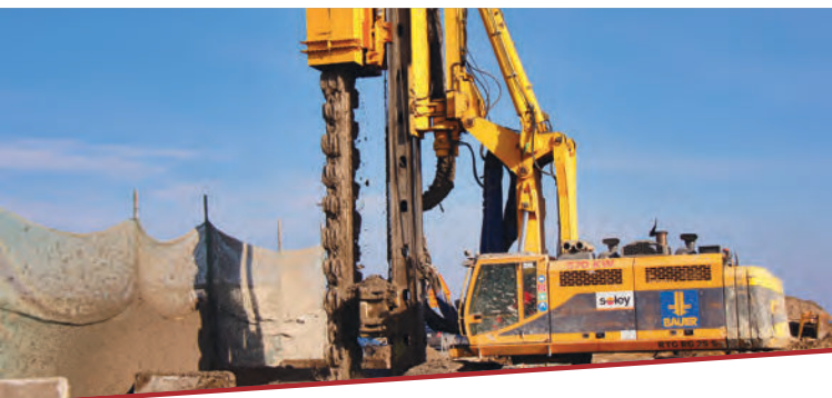
Fot. 1. Realizacja przesłony przeciwfiltracyjnej – wykorzystanie narzędzia TFoW.
